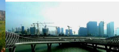
△在阅湖台上远望新城在建风貌。
